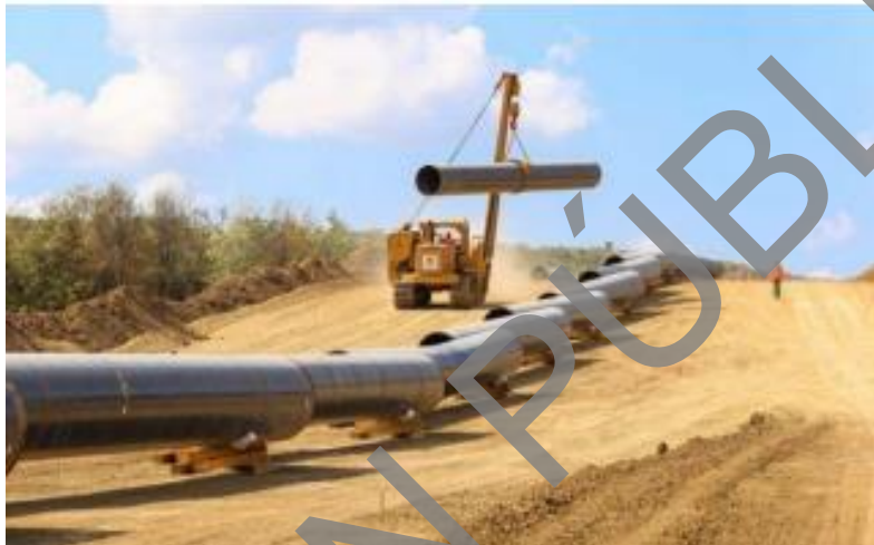
FIGURA 1 EJEMPLO DE TENDIDO DE TUBERÍA
