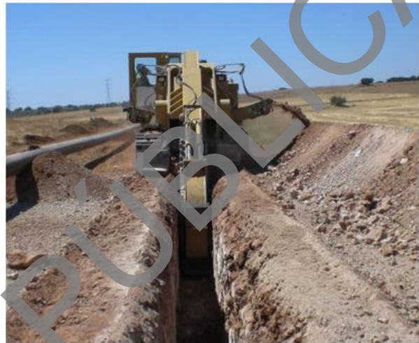
EXCAVACIÓN CON ZANJADORA
