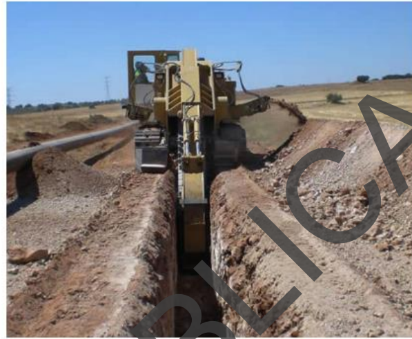
EXCAVACIÓN CON ZANJADORA
