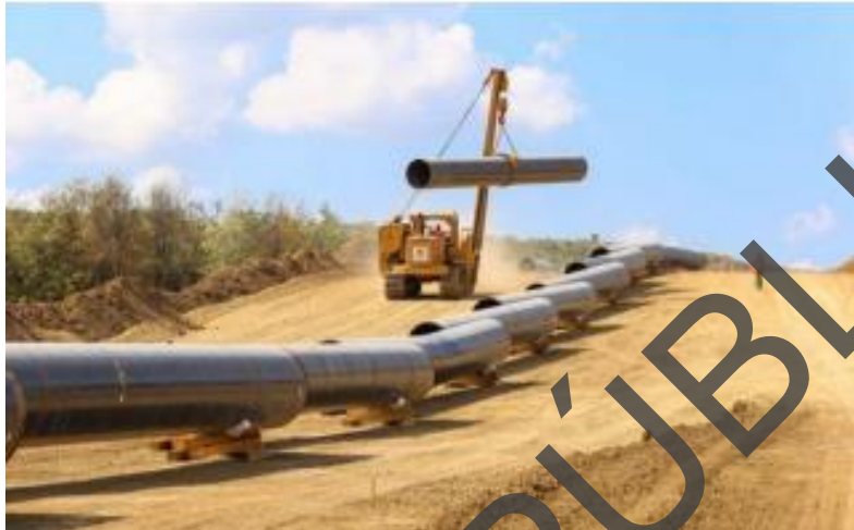
FIGURA 1 EJEMPLO DE TENDIDO DE TUBERÍA
