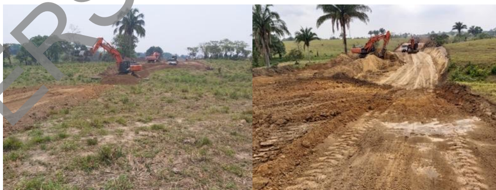
Figura 1--3. Ejemplo de desmonte y despalme
