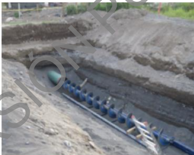
Figura 1--17. Ejemplo de perforación horizontal
