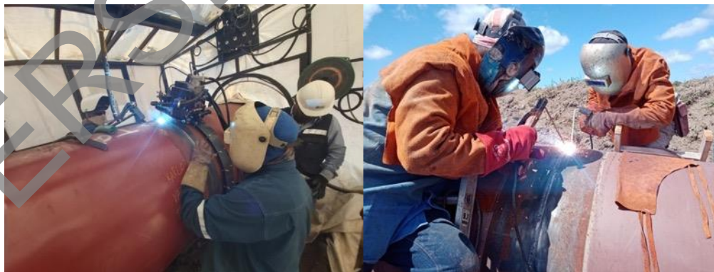
Figura 1--12. Ejemplo de soldadura automática y manual.
