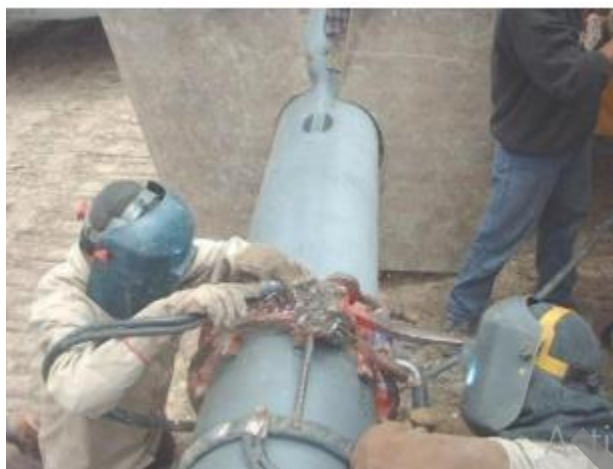
Figura 1--11. Ejemplo de alineado de tuberías
