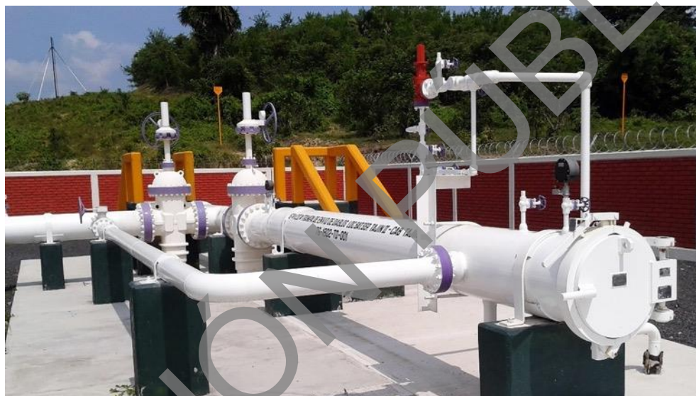
Figura 1—20. Ejemplo de trampa de diablos
