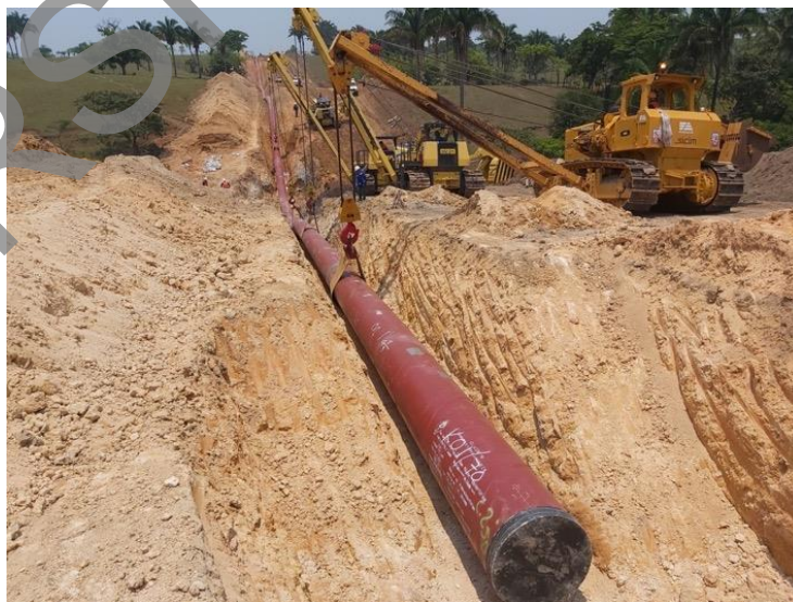
Figura 1--14. Ejemplo de bajado de tubería
