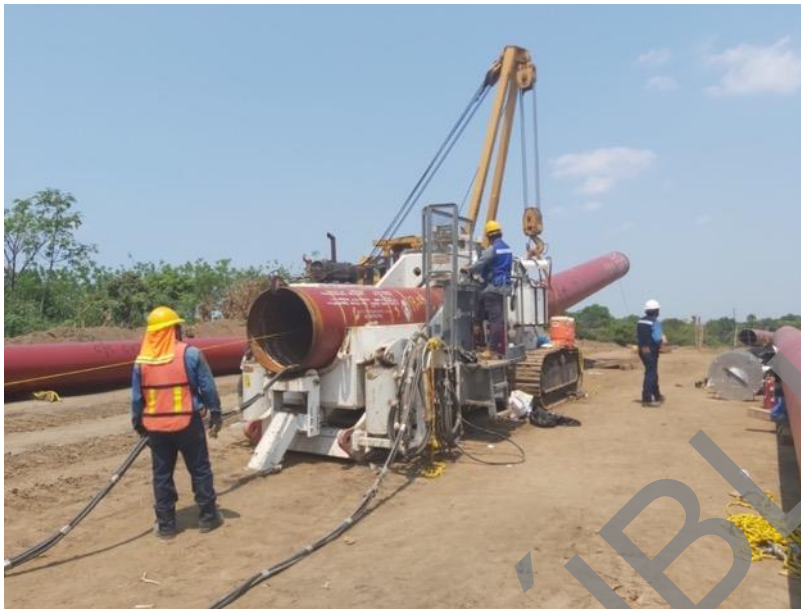
Figura 1--10. Ejemplo de doblado de tubería
