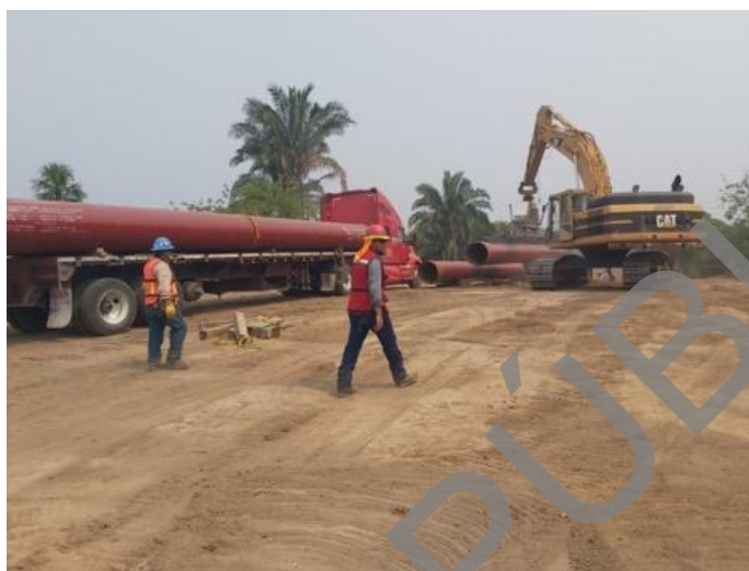
Figura 1--9. Ejemplo de tendido de tubería
