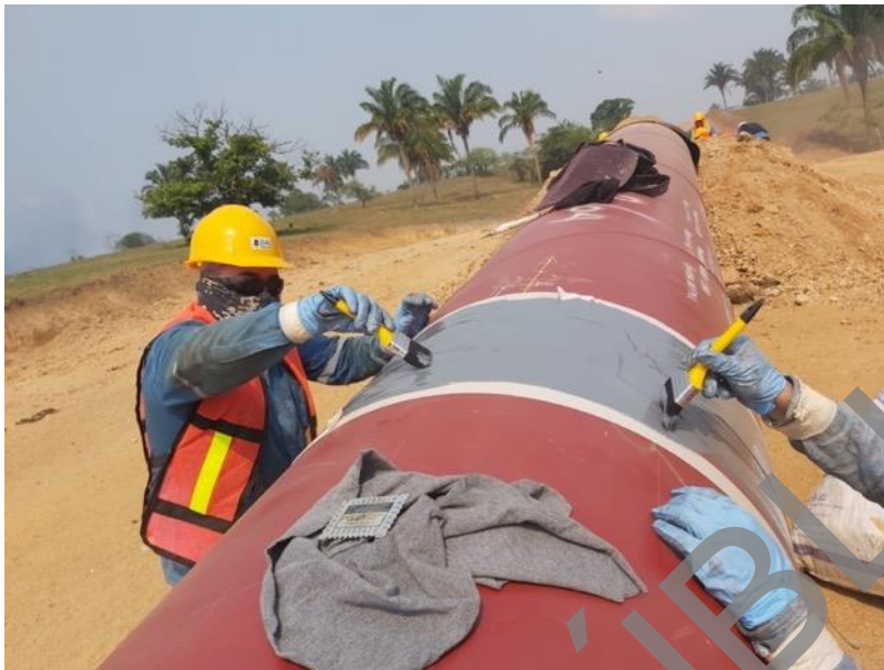
Figura 1--13. Ejemplo de recubrimiento en juntas de tubería.
