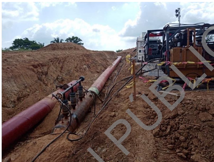
Figura 1--19. Ejemplo de prueba hidrostática
