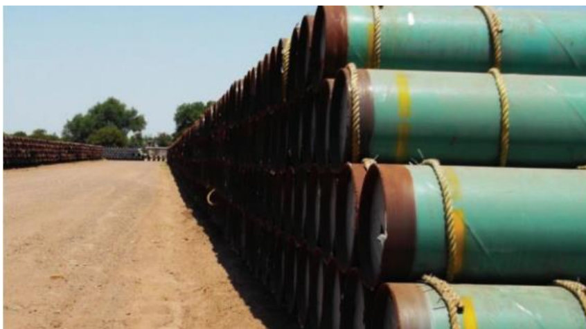
Figura 1-5. Ejemplo de patio de acopio de la tubería
