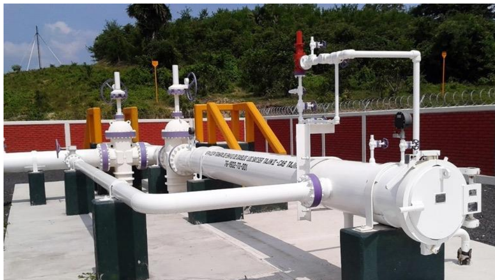
Figura 1-20. Ejemplo de trampa de diablos
