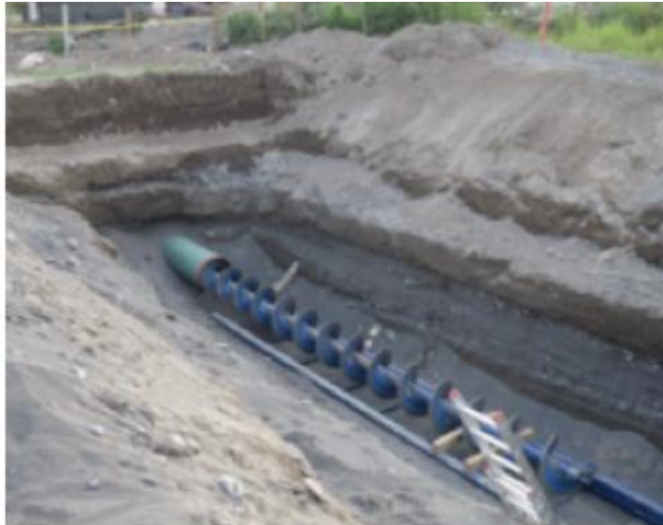
Figura 1-17. Ejemplo de perforación horizontal
