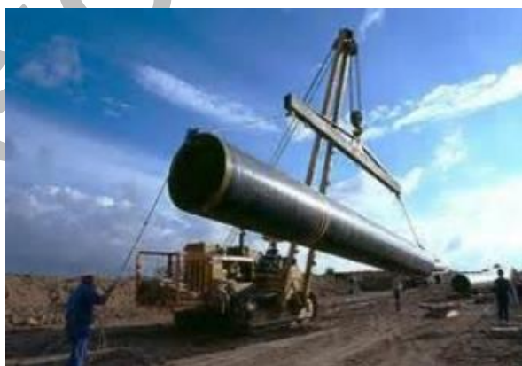
Figura 1-8. Ejemplo de descarga de tubería
