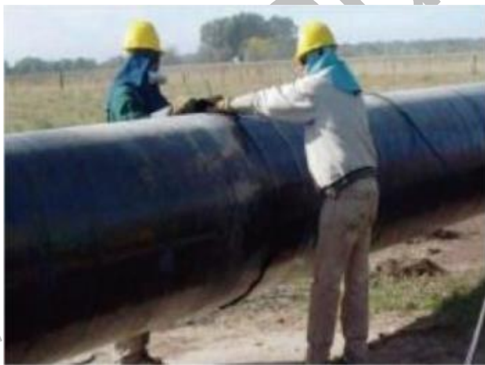
Figura 1-13. Ejemplo de parcheo de tuberías
