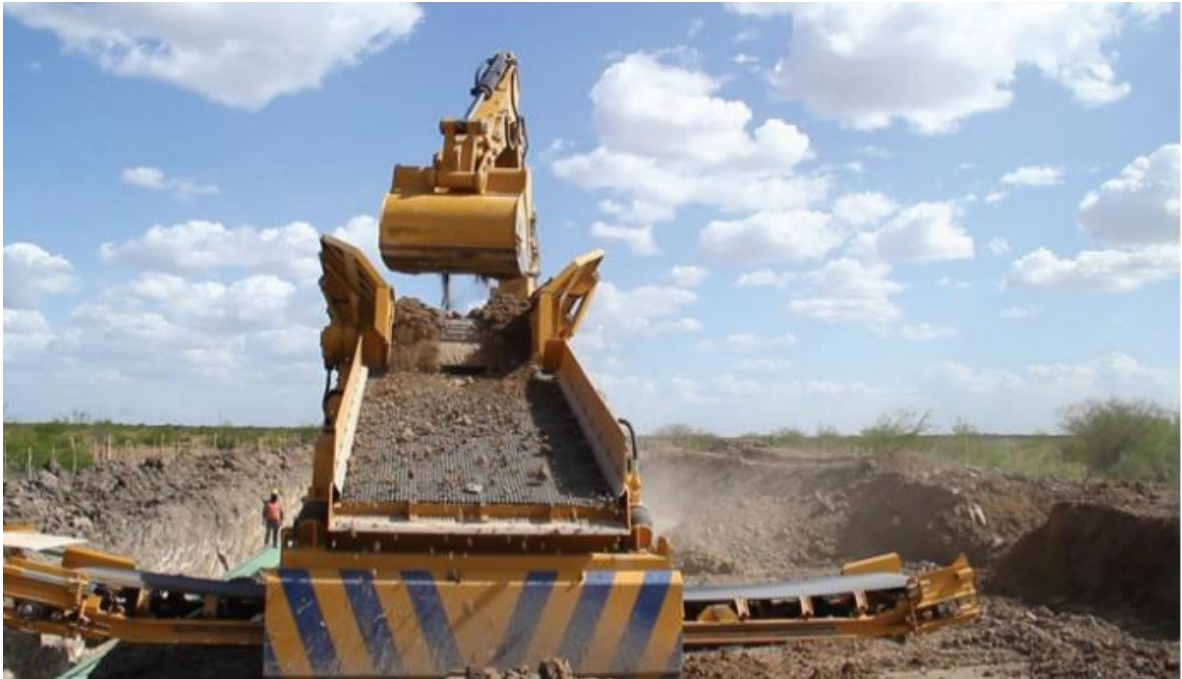
Figura 1-15. Ejemplo de tapado de zanja
