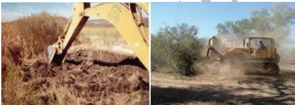
Figura 1-3. Ejemplo de desmonte y despalme
