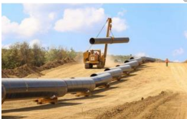
Figura 1-9. Ejemplo de tendido de tubería
