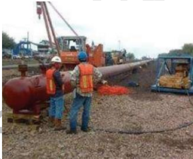
Figura 1-19. Ejemplo de prueba hidrostática
