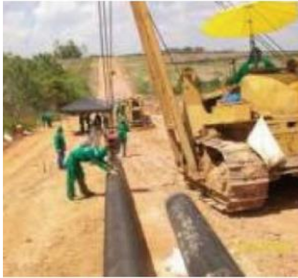
Figura 1-10. Ejemplo de doblado de tubería
