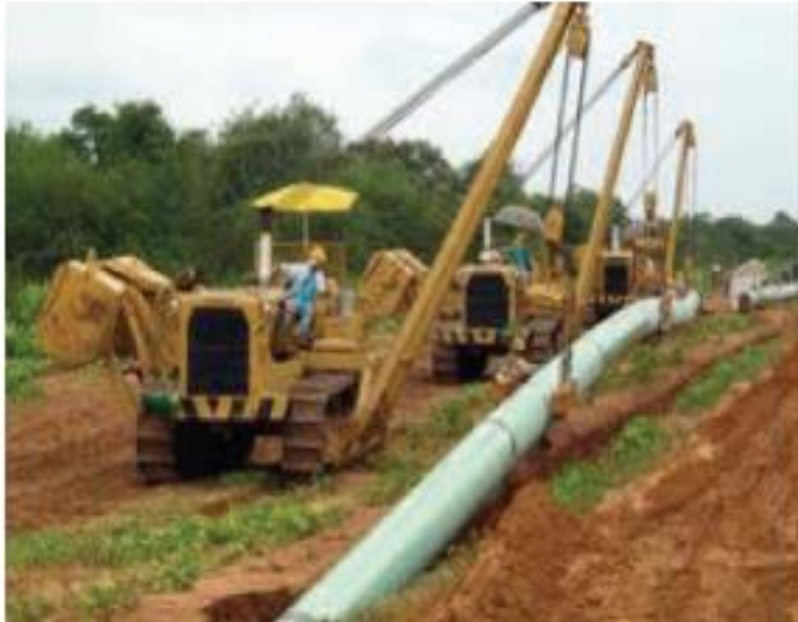
Figura 1-14. Ejemplo de bajado de tubería
