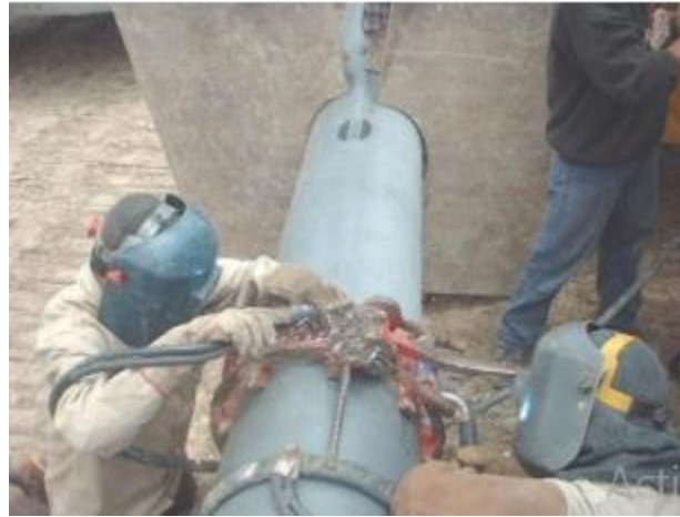
Figura 1-11. Ejemplo de alineado de tuberías
