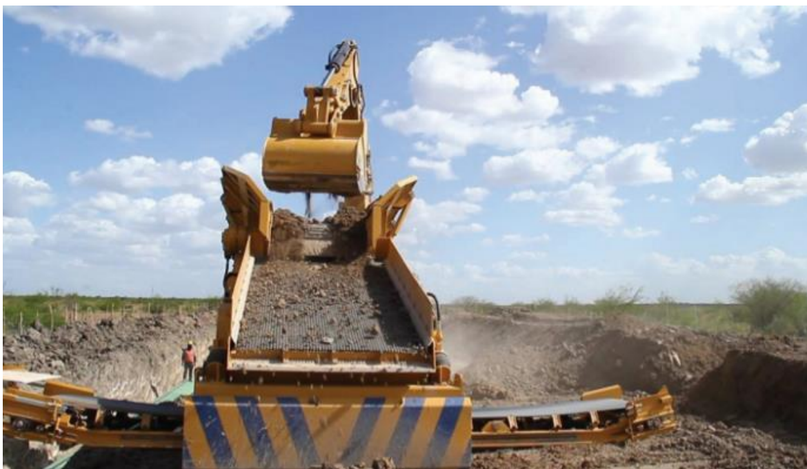
Figura 1-15. Ejemplo de tapado de zanja
