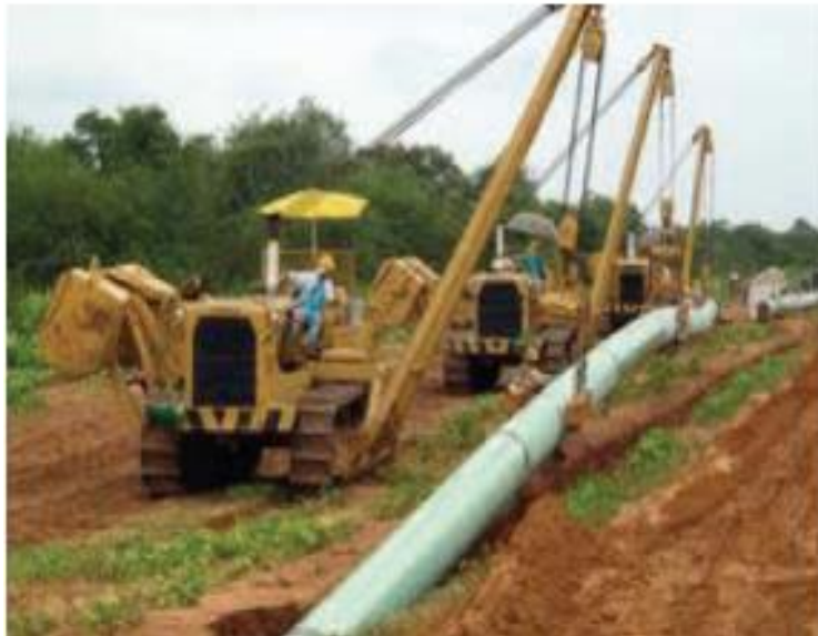
Figura 1-14. Ejemplo de bajado de tubería
