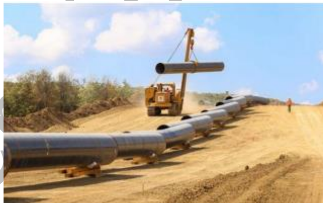
Figura 1-9. Ejemplo de tendido de tubería
