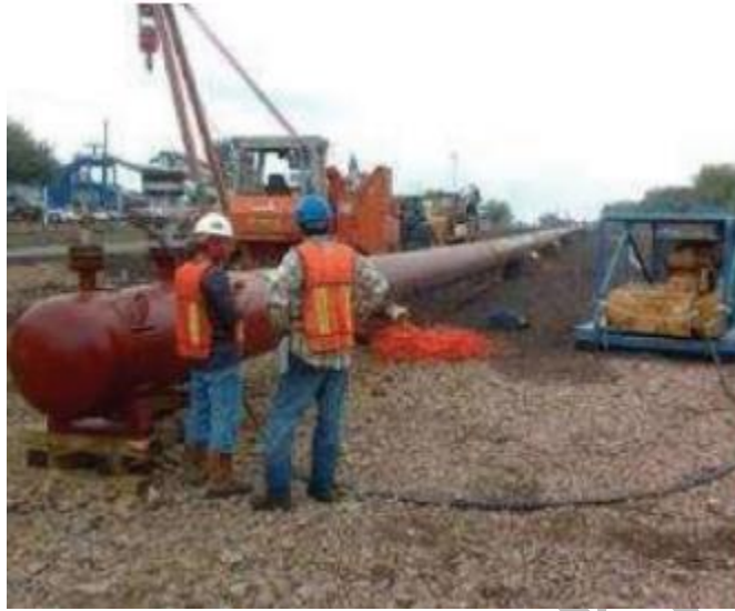
Figura 1-19. Ejemplo de prueba hidrostática
