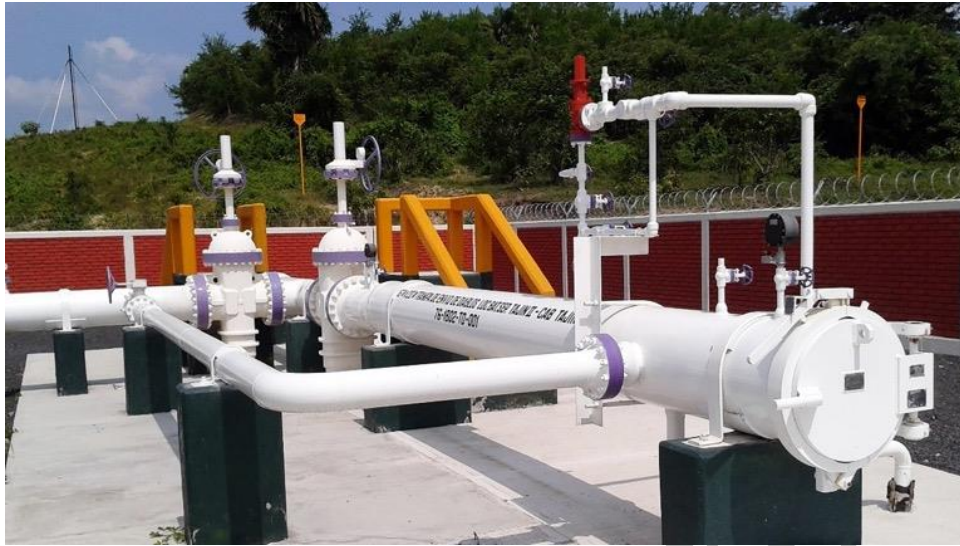
Figura 1-20. Ejemplo de trampa de diablos
