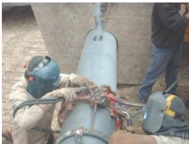
Figura 1-11. Ejemplo de alineado de tuberías
