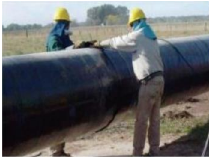
Figura 1-13. Ejemplo de parcheo de tuberías
