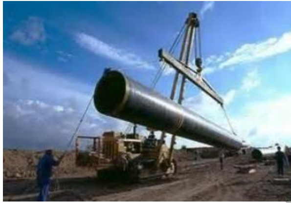
Figura 1-8. Ejemplo de descarga de tubería
