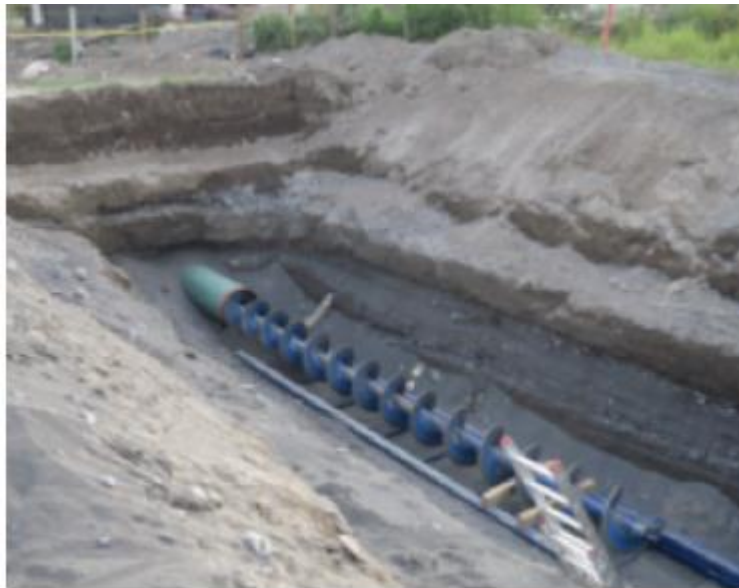
Figura 1-17. Ejemplo de perforación horizontal
