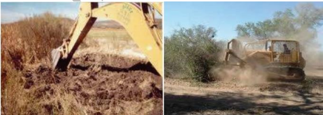
Figura 1-3. Ejemplo de desmante y despálme
